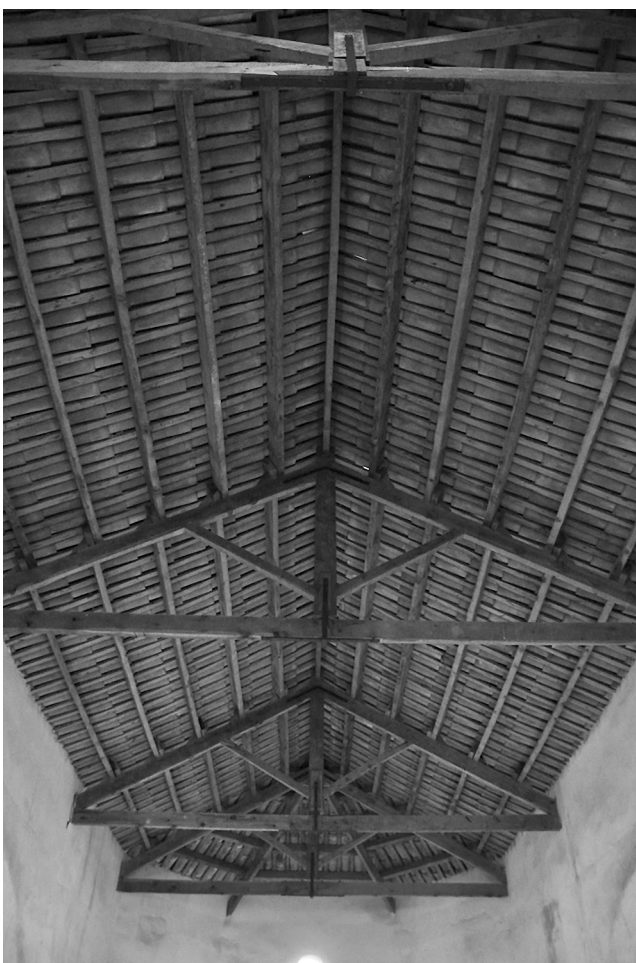
Encavallada de la teulada construïda de nou després de la guerra.
