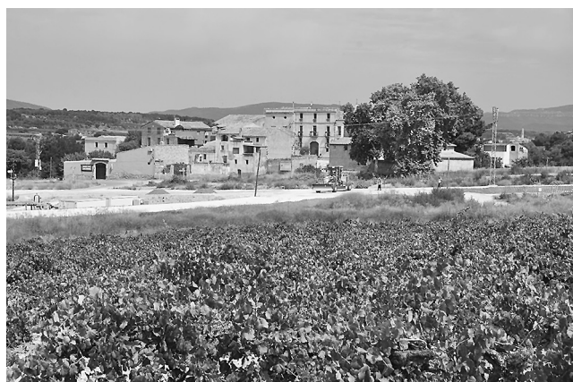
Vilardida immersa ara en les obres de desviament de la carretera C-51
