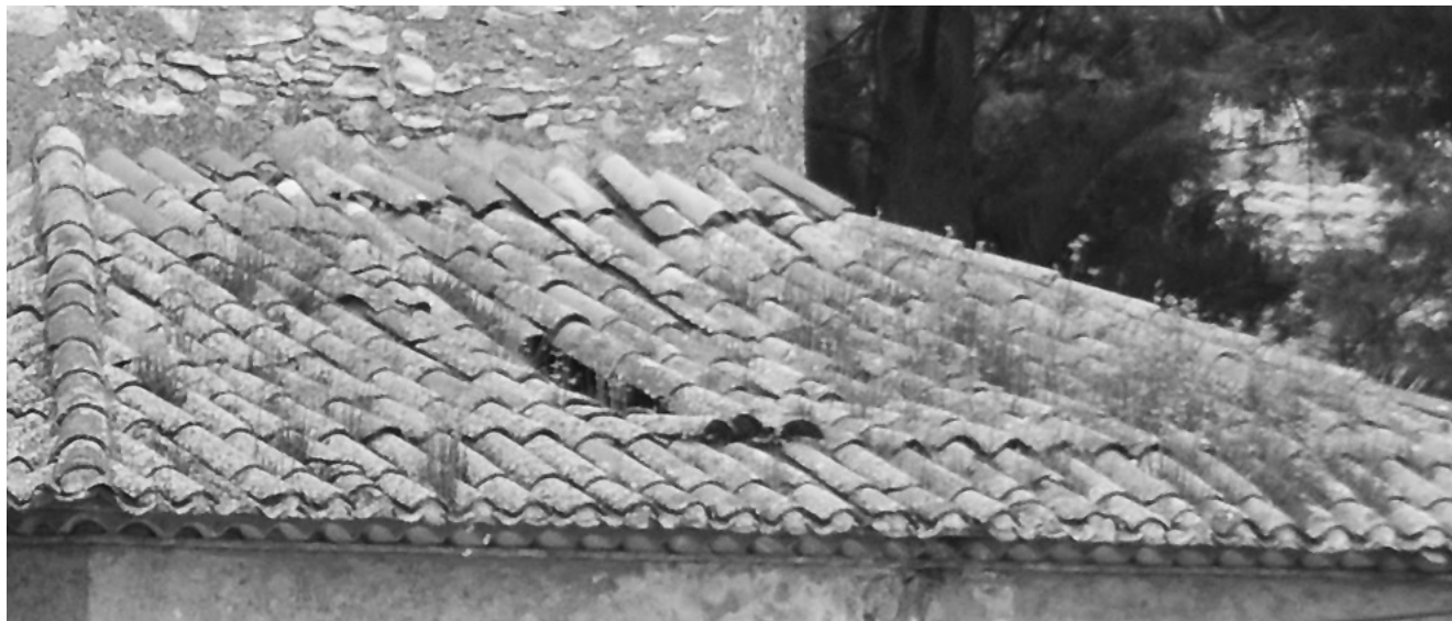
Mal estat actual de la teulada de la sagristia.
