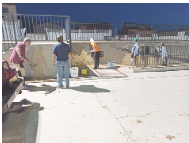
Arranjant les instal·lacions del Casal.
