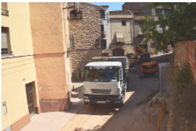
Construcció del nou col·lector d'aigües residuals.
