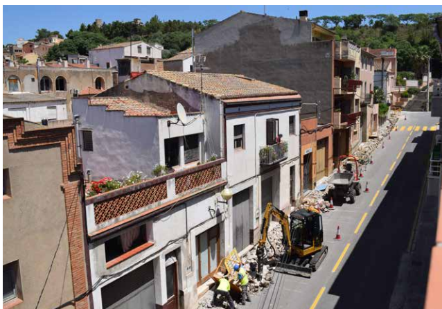
Inici de les obres al carrer Mossèn Galofré
