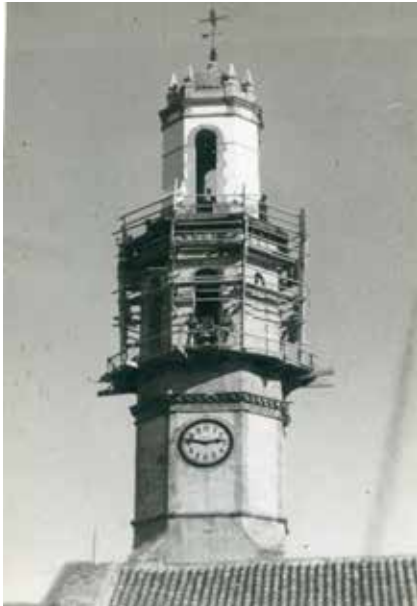
Bastida a mig campanar amb els paletes treballant-hi. La part de dalt ja estava reformada.
