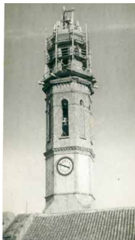
Obres de reconstrucció del campanar. La bastida a dalt de tot.
