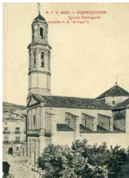
El campanar cap a 1914 amb mostres de deteriorament de les parets.
