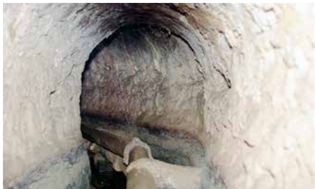
Tubs de l'aigua potable per dins de la Mina de la Trona. Any 1991.
