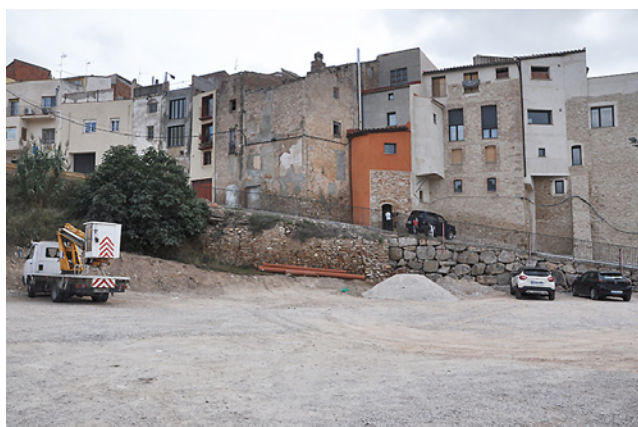
Aparcament i cases del carrer Marià Fortuny, la «Muralla».
